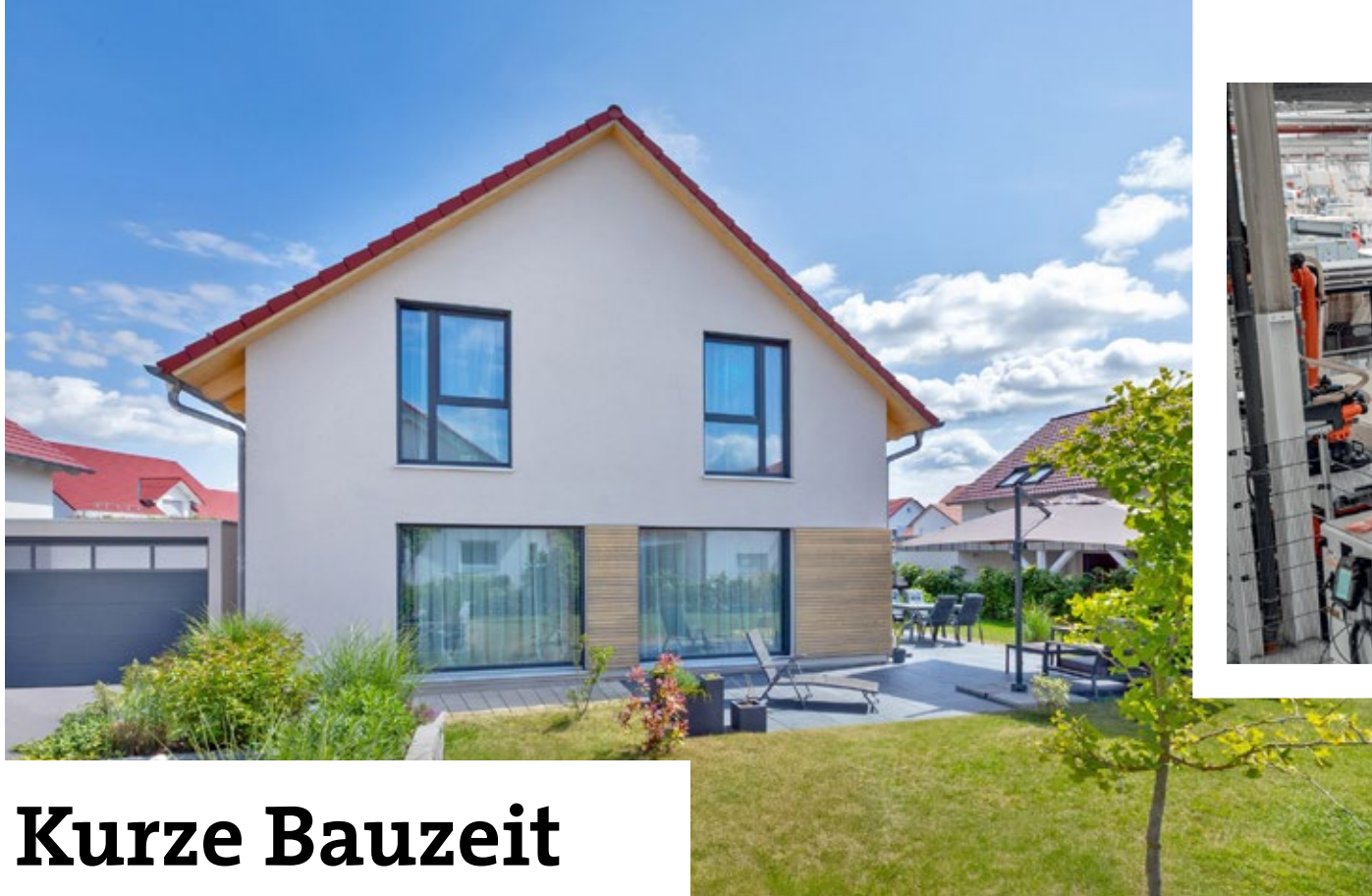
Foto: BDF/Talbau-Haus/ Corinna Holzer
