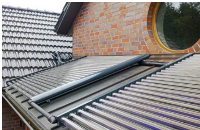
Vollvakuumröhrenkollektoren sind für hohe Effizienz, langlebigen Betrieb und flexible Montage ausgelegt. Diese Röhrenkollektoren können auch an der Fassade oder am Balkongeländer angebracht werden.
