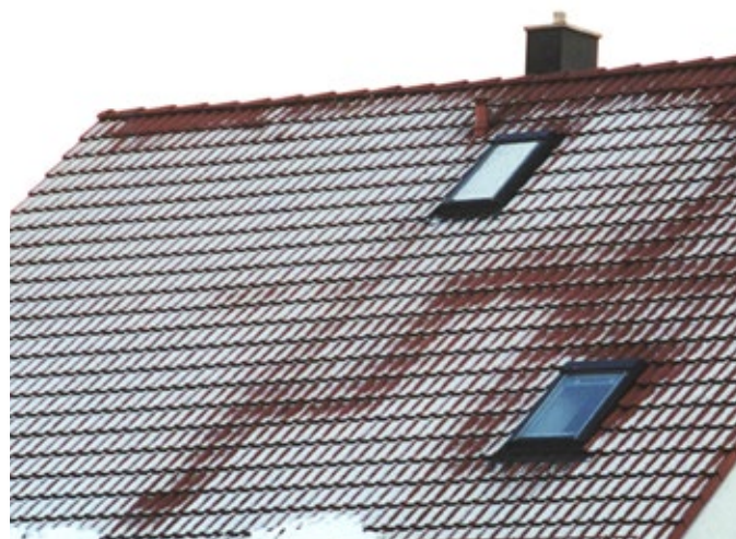
Auf der Dachfläche zeichnet sich deutlich der Grundriss der Wohnung ab. Hier besteht Sanierungsbedarf bei der Wärmedämmung. Fotos: HF.Redaktion
