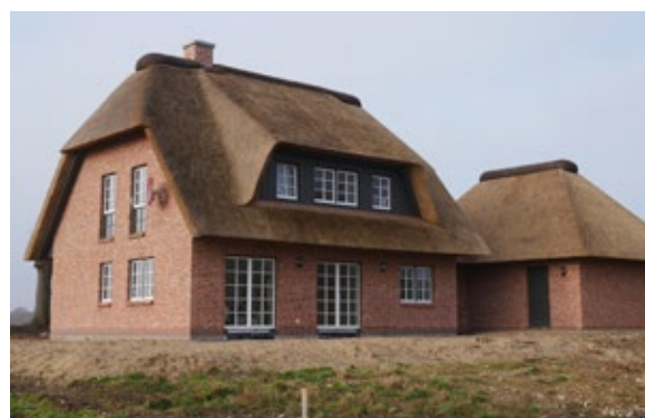
AB-Haus Inhaber Sebastian Carstensen- Lilienthal ist selbst Maurer- und Betonbaumeister. Er beschäftigt 20 Mitarbeiter aus unterschiedlichen Gewerken.
