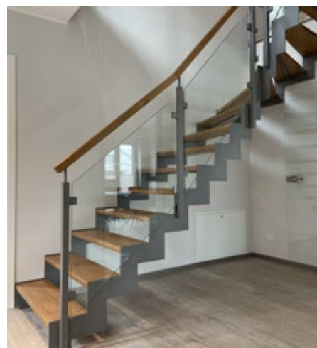
Flachstahl-Wangentreppe mit Eichenstufen, Glasgeländer, eckigem Holzhandlauf und quadratischen Stahlposten
