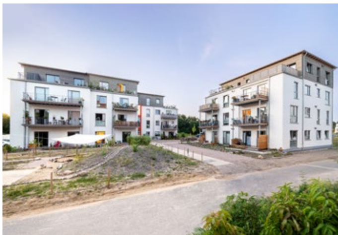
Architekt Dirk Scharmer stellt zwei viergeschossige Neubauten vor, die in einer Kombination aus Holz-, Stroh- und Lehmbauweise errichtet wurden.
