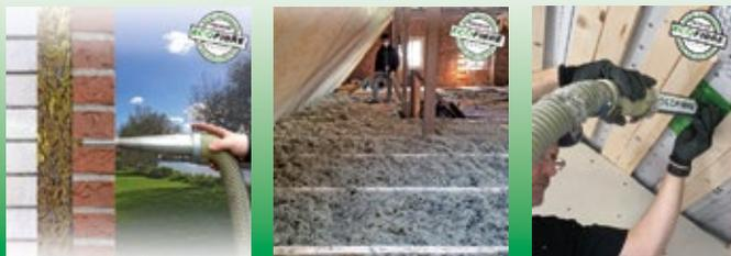
Einblasdämmung für Mauerwerk, Dachböden & -schrägen
