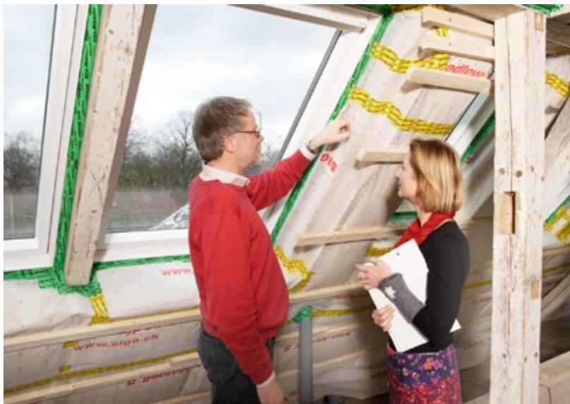
Auch am Dachflächenfenster muss die Luft- und Dampfsperre dicht angeschlossen werden. Dabei ist für den Anschluss der Folie an das Fenster ein anderes Klebeband zu verwenden als für die Folien untereinander.
