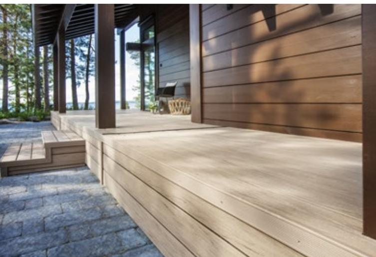
Die WPC Terrassendielen sind ein Recycling-Produkt, zu dem ausschließlich Plastik- und Papierabfälle aus der Etikettenproduktion und Kunststoffabfälle verwendet werden.
