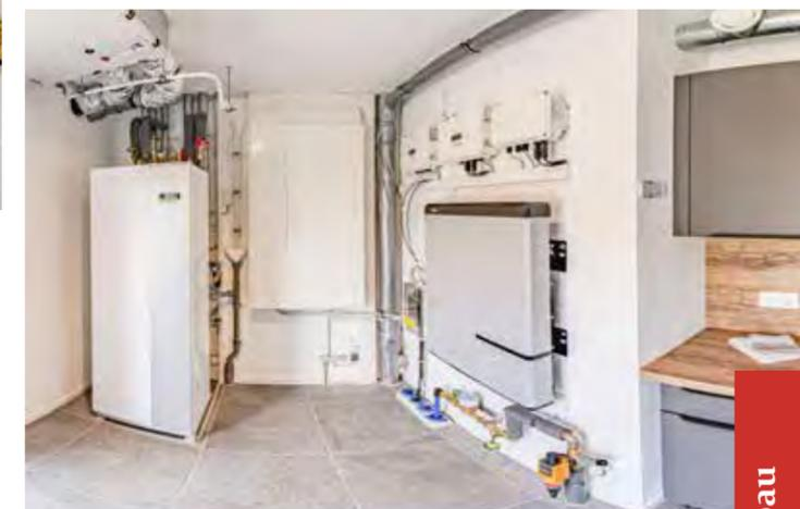
Diese verfügen über eine exzellente Gebäudehülle, moderne Wärmepumpentechnik, hocheffiziente Photovoltaikanlagen zur Sonnenstromerzeugung, Hausbatterien zur Stromspeicherung und moderne Energiemanagementsysteme.
