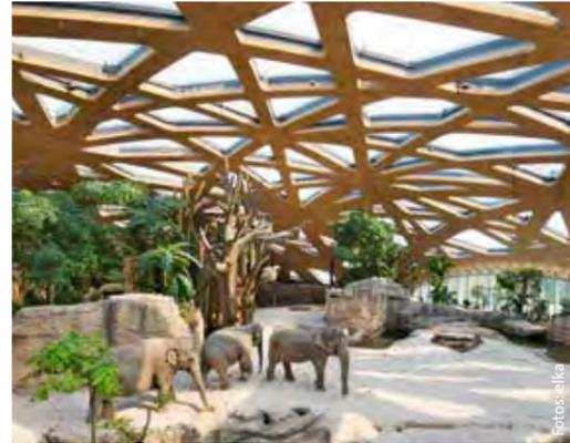
Starke Platten für das Elefantenhaus im Zürcher Zoo. 4.000 m<sup>2</sup> esb-Platten wurden in der imposanten Dachkonstruktion verbaut.
