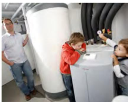
Eine Wärmepumpe erschließt mit einem Teil Strom drei Teile Umweltwärme und liefert so Heizenergie
