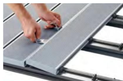
und Knie geschont und Zeit gespart wird. Jedes Einzelteil des Systems ist innovativ design, erfüllt höchste Ansprüche und reduziert die Verlegezeit um 50–70 %. Weder bei der Unterkonstruktion noch beim Decking ist Bohren oder Schrauben nötig. Und das Beste: fast alle vorbereitenden Arbeiten können auf Arbeitsbankhöhe durchgeführt werden, wodurch sich die auf Knien vornübergebeugte Arbeitszeit wesentlich reduziert.
