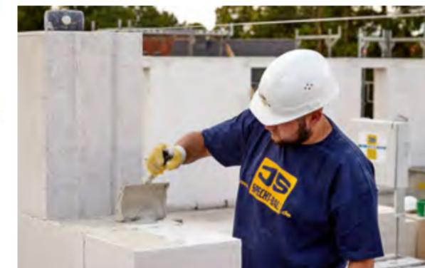
H+H Multielemente können von nur zwei Maurern mit einem Mikrokran sicher und schnell bei geringer körperlicher Beanspruchung verarbeitet werden.
