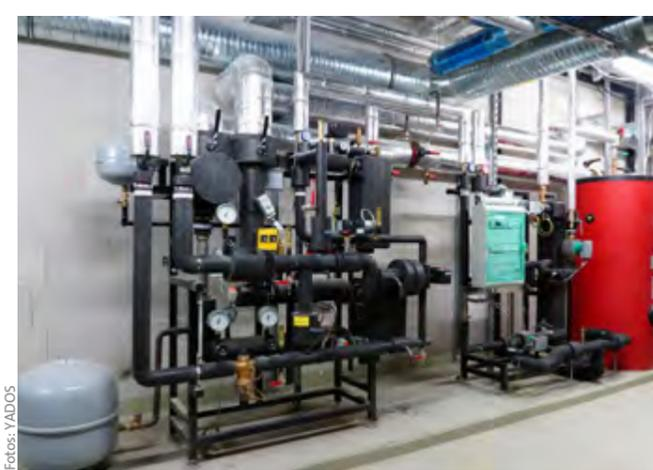
Wärmeübergabestation mit Heizkreis und Trinkwassererwärmungssystem
