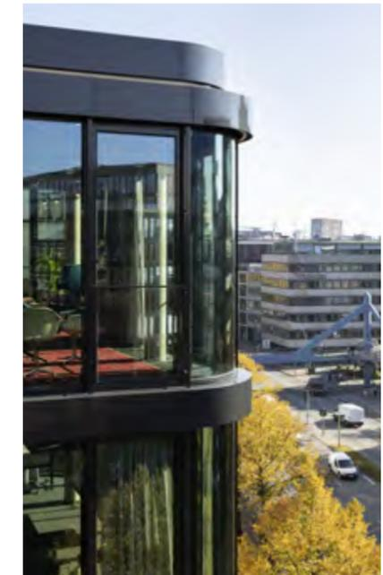
Das denkmalgeschützte dreistöckige Kontorhaus aus dem Jahr 1911 wurde um zwei Etagen aufgestockt, deren Fassade mit Metallpaneelen verkleidet sind. Zudem wurde das Haus um einen sechsgeschossigen gläsernen Turm erweitert.
