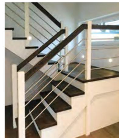
Die aufgesattelte Podesttreppe mit liegenden Edelstahlgurten ermöglicht eine gute Alternative zur eingestemmt Treppe.
