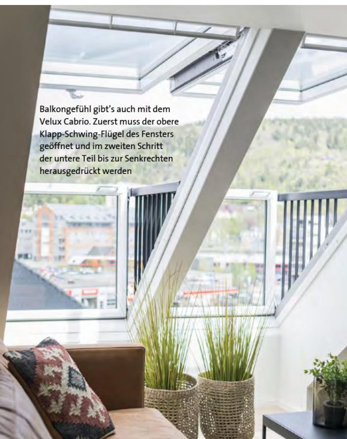
Balkongefühl gibt's auch mit dem Velux Cabrio. Zuerst muss der obere Klapp-Schwing-Flügel des Fensters geöffnet und im zweiten Schritt der untere Teil bis zur Senkrechten herausgedrückt werden
