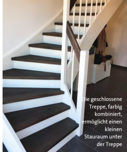
Die geschlossene Treppe, farbig kombiniert, ermöglicht einen kleinen Stauraum unter der Treppe
