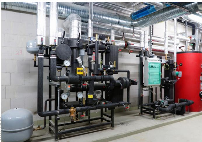
Wärmeübergabestation mit Heizkreis und Trinkwassererwärmungssystem
