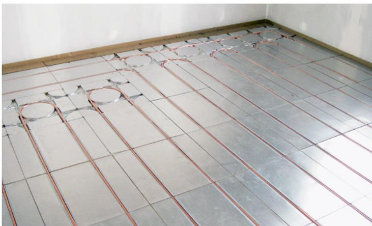
oben: Nur mit abgestimmter Hydraulik kommt bei Fußbodenheizungen wirklich Freude auf
