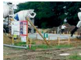
Vom Estrich bis zur Schlüsselübergabe, PE Massivhaus begleitet jedes Bauvorhaben intensiv
