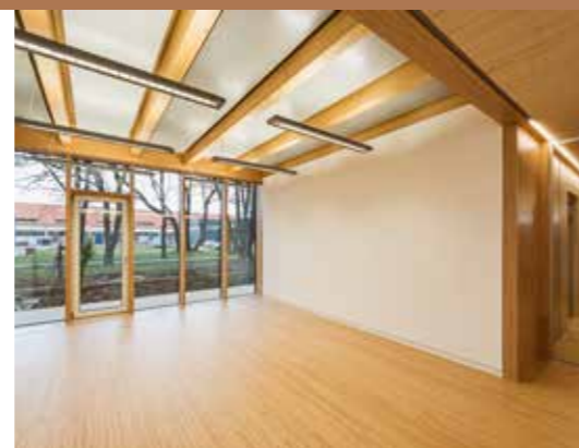
Der Neubau der Firmenzentrale der euregon AG ist ein besonders innovatives Bauwerk, das in Holzskelettbauweise aus Bau-Buche errichtet wurde
