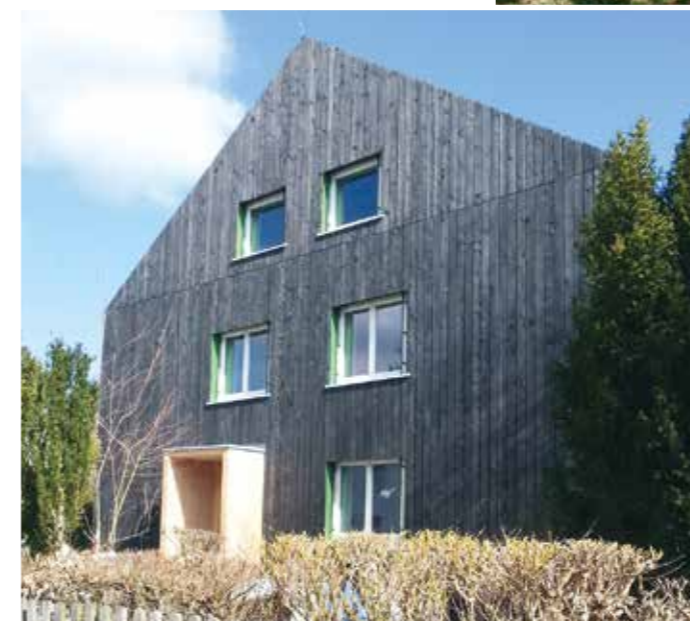
Die energetische Sanierung des Amtes wurde mit der Zielsetzung einer ökologischen und zukunftsweisenden Ertüchtigung der Gebäudehülle durchgeführt
