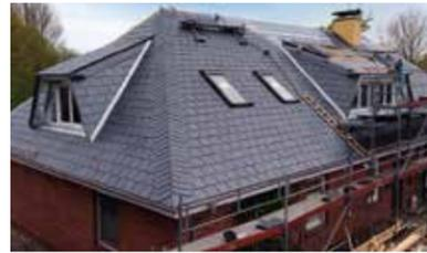
Bauklempnerei und der Einbau von Wohndachfenstern gehören ebenfalls zum Leistungsspektrum des ausgezeichneten Dachdeckerbetriebes. MP
