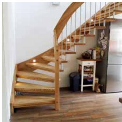
Die Einwangentragbolzentreppe in Esche mit seitlichen LED-Lichtern ermöglicht auch abends einen sicheren Aufstieg
