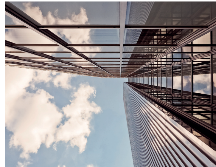
Glasfassaden sind auch ein zentrales Gestaltungselement zeitgenössischer Architektur
