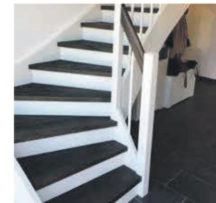
Die geschlossene Treppe, farbig kombiniert, ermöglicht einen kleinen Stauraum unter der Treppe
