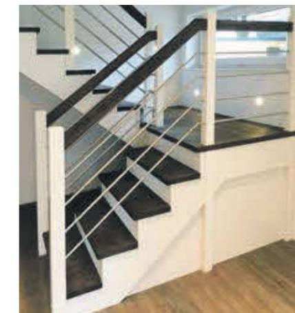
Die aufgesetzte Podesttreppe mit liegenden Edelstahlgurten ermöglicht eine gute Alternative zur eingestemmten Treppe
