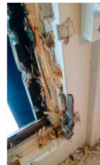
Nach Öffnung des Fensters erkennt man den Schaden – die Pilzköpfe haben aber gehalten
