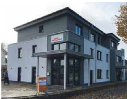
Das neue Firmengebäude über zwei Etagen in der Rendsburger Straße 147 in Neumünster
