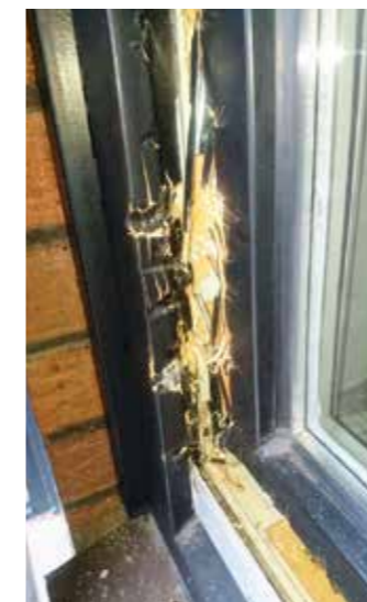
Gescheiterter Einbruchversuch: Das mit Pilzkopfverriegelung ausgestattete Fenster bleibt zu
