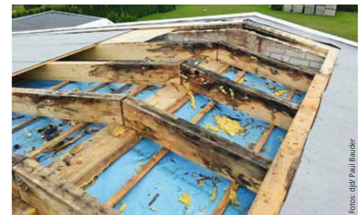
Feuchteschäden können teure Renovierungsarbeiten erforderlich machen
