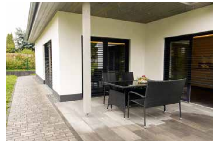
Das Unternehmen VarioSelf baut individuelle Plusenergiehäuser aus natürlichem Blähton
