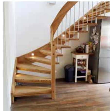
Die Einwagentragbolzentreppe in Esche mit seitlichen LED-Lichtern ermöglicht auch abends einen sicheren Aufstieg
